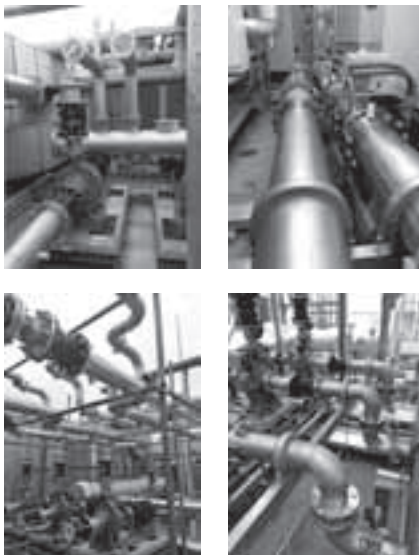
写真 1SGPをSUS430LXに管種変更した事例
